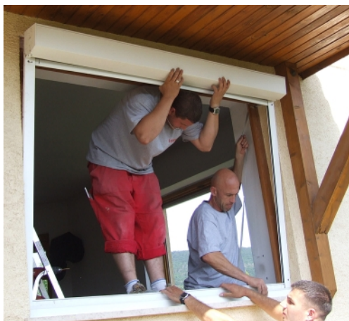
A beépített nyílászárókat eltávolítják a falnyílásból.
