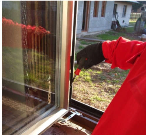
Szárny felszerelése.
